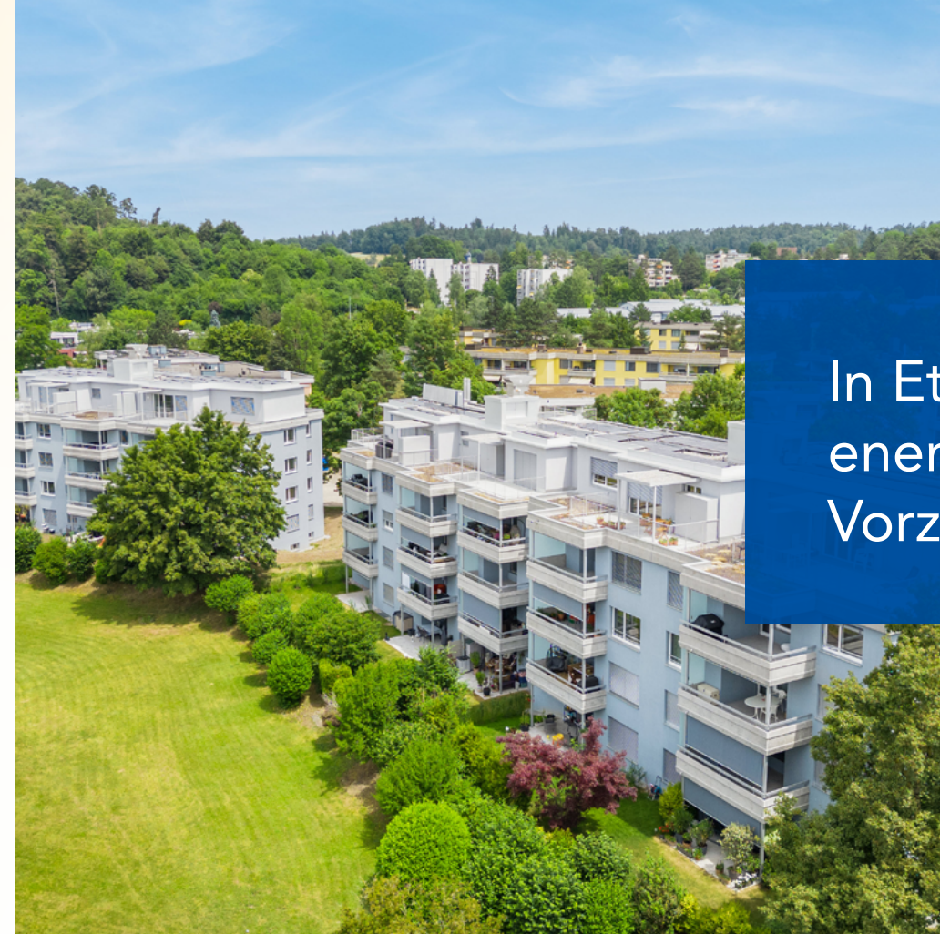
Die Liegenschaft am Mythenweg nach der Sanierung und Aufstockung.
